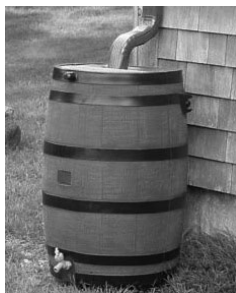
Figura 4 – Barril para armazenamento de água de chuva
