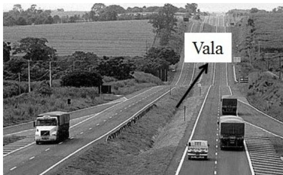
Figura 8 – Vala de infiltração
